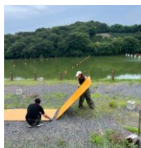
砂利の多い場所を車いすでも移動できるように、コンパネを敷いて栈橋へのアプローチ作り
